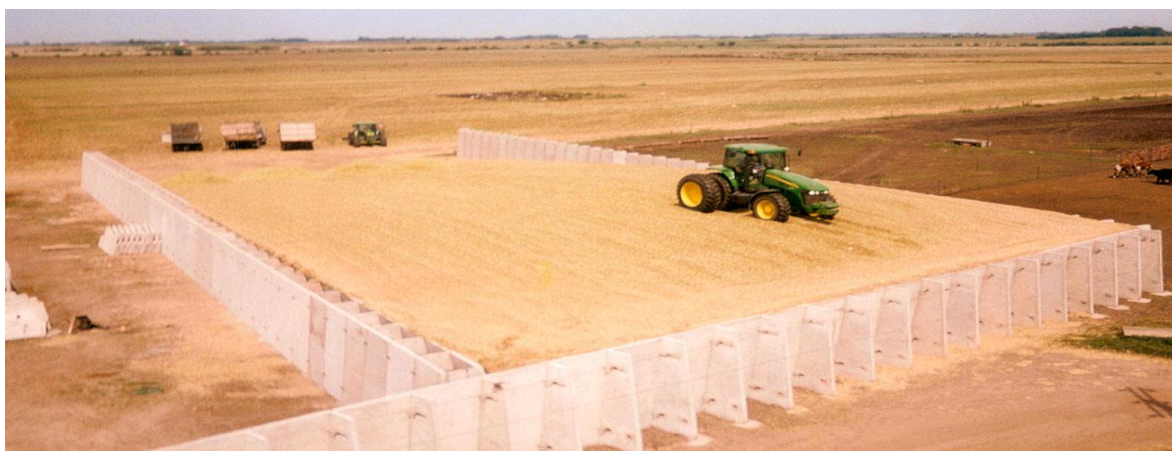
Figura 60. Silo tipo bunker.
